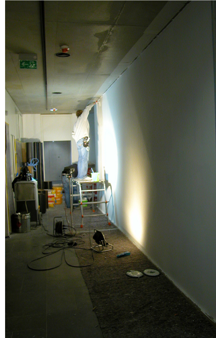
08.11.2011: Voranstrich mit grauer Farbe, damit die weiße Farbe nicht unter die Punkte laufen kann
