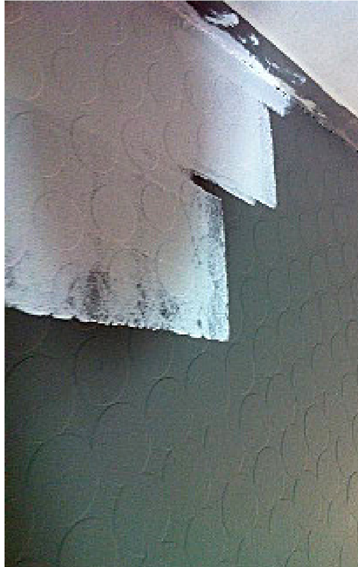
08.11.2011: Voranstrich mit grauer Farbe, damit die weiße Farbe nicht unter die Punkte laufen kann
